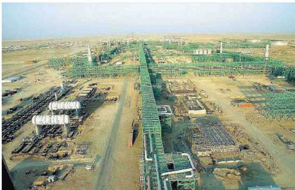
Bonatti Un cantiere del gruppo parmigiano in Kazakistan.
